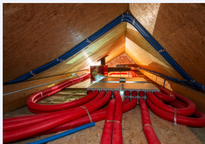
Les installations techniques d'échange d'air prennent place sous le pignon.
