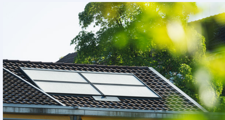
Les capteurs solaires alimentent la maison en eau chaude.
