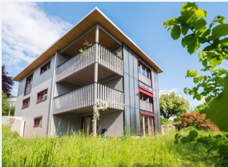
L'étage des combles a été remplacé par une structure en bois et transformé en appartement familial. L'étage en sous-sol à flanc de coteau accueille désormais un studio.
